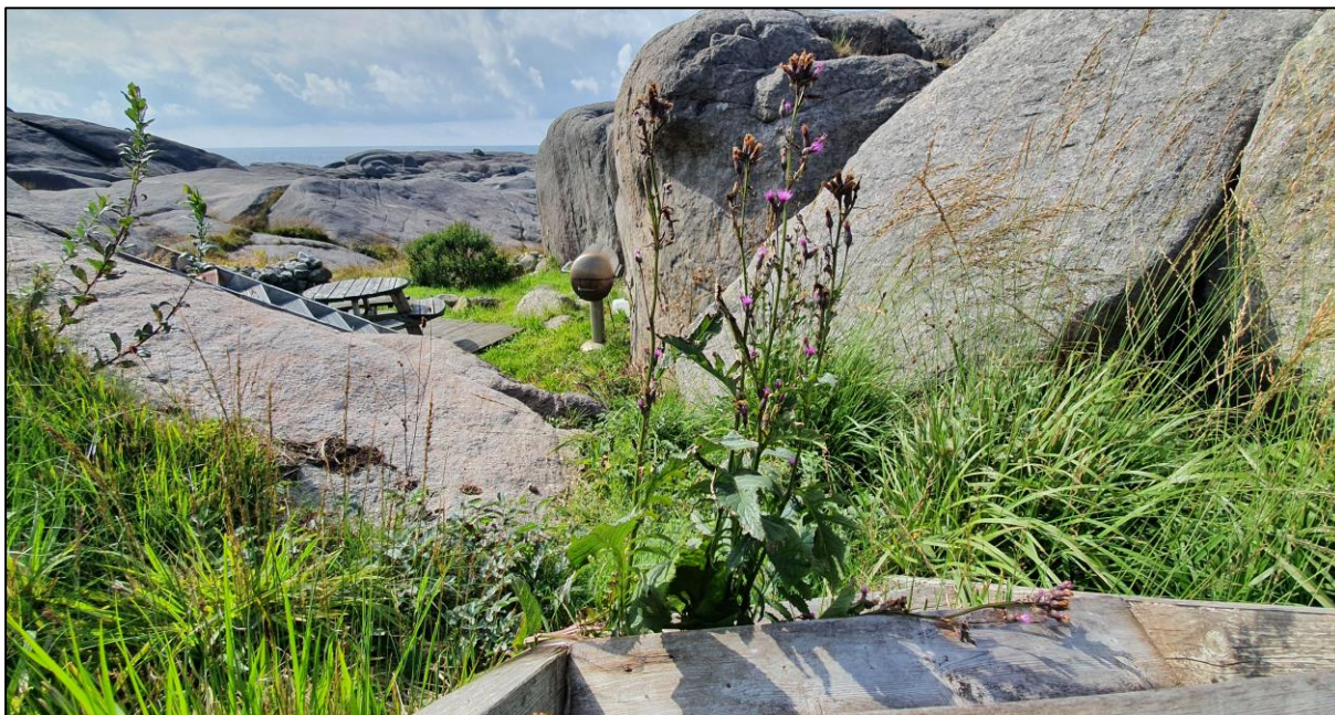
Figur 34. Jærtistelen vokste gjennom trappen ved befaring i 2020. Foto: Knut Børge Strøm.
